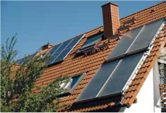
Besonderes Augenmerk legt die Emscher-Lippe-Region auf einen klimagerechten Stadtumbau.
