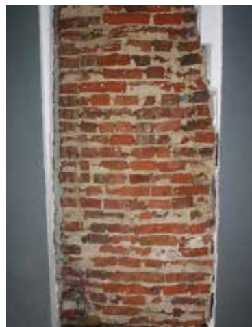
Mauerreste finden sich sogar mitten in Häusern im Ortskern.
